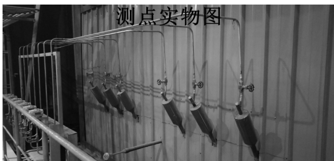
图2 炉膛测点
