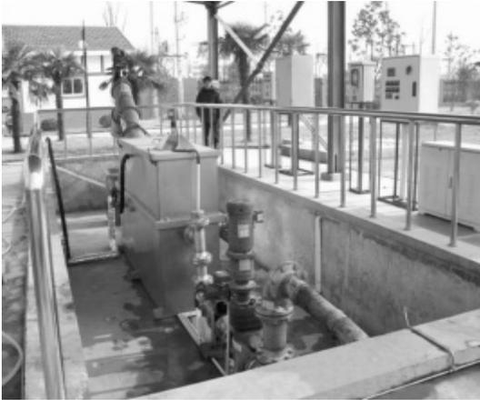
图 2 一体化固液分离系统现场图
