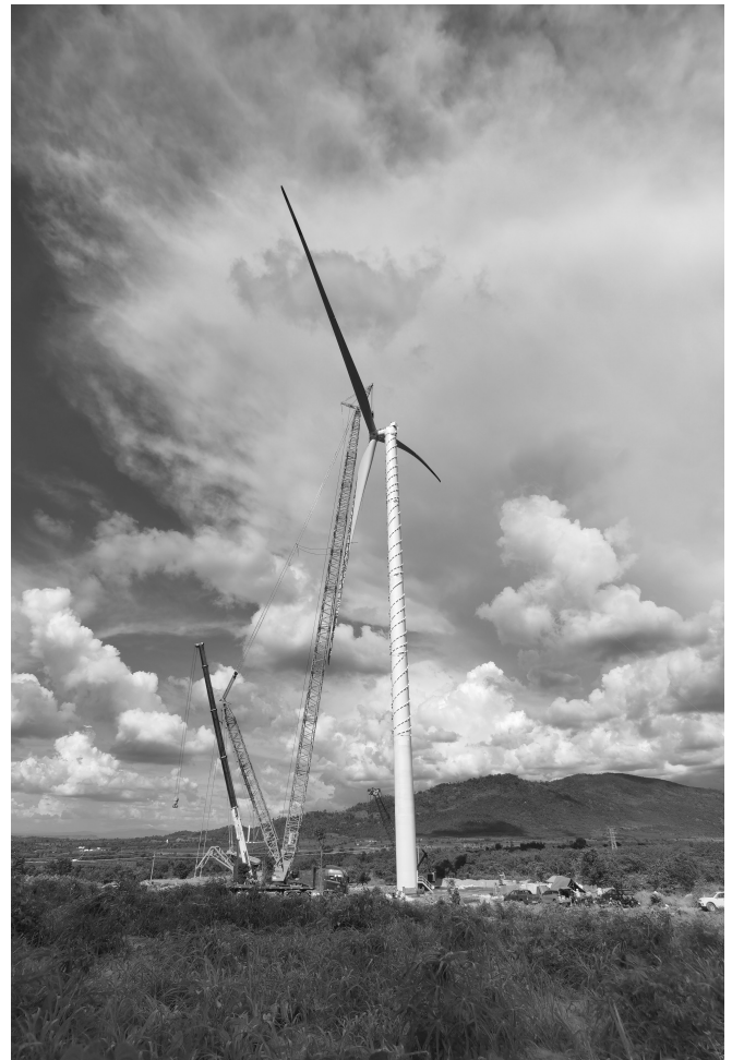
图2 风电工程风机安装现场实拍图
